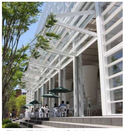
▲開放された折戸。美術館に爽やかな風が吹き抜けました
